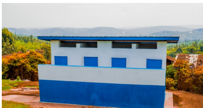
Bloc des latrines séparées hommes/femmes construit au CDS MURIMA dans la commune Kayanza avec l'appui de l'Unicef Burundi
