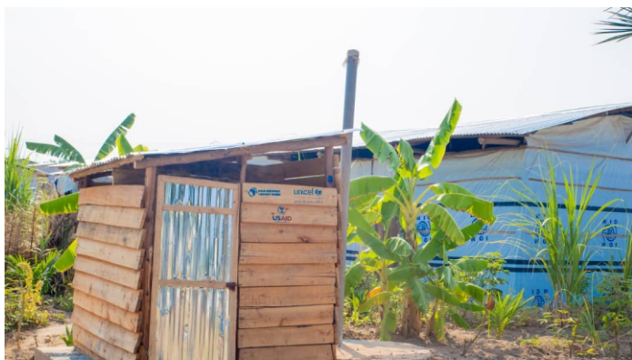
Photo d'une latrine construite en sémi-durable dans le site des déplacés internes de Mutambara à Rumonge
