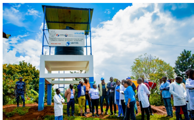
Image prise lors de l'inauguration des ouvrages WASH réalisés dans 10 FOSA de Kayanza, Kirundo et Muyinga avec l'appui de l'Unicef Burundi
