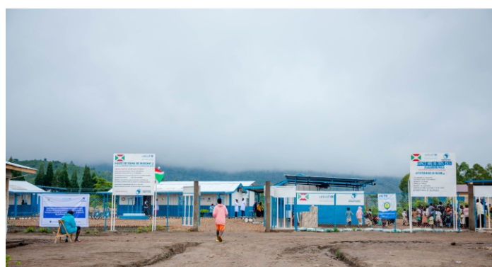
Vue partielle du poste de soins de Musenyi 2 aménagé par GDCB avec l'appui de l'Unicef en faveur des réfugiés congolais
