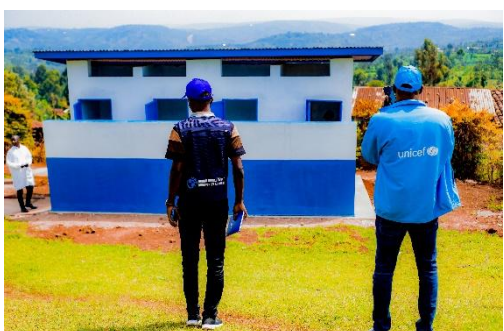
Supervision des travaux GDCB-UNICEF
