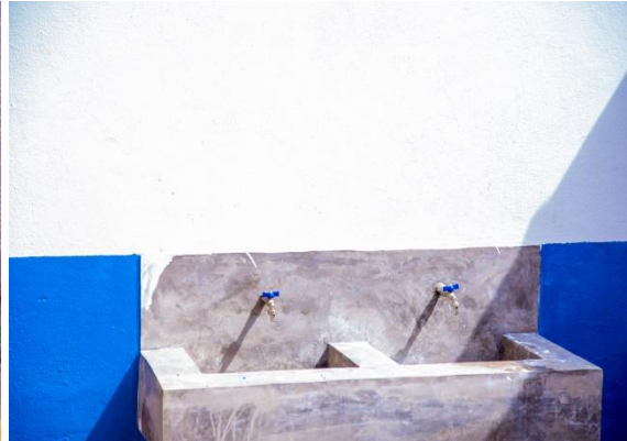
Point d'eau construit
