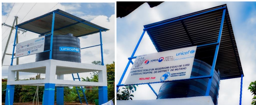
1 er Polytank de 5000L Installé
