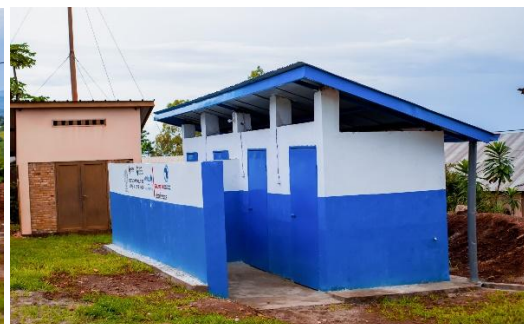
Latrines et douches construites
