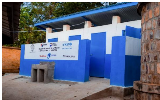
Bloc de deux toilettes et deux douches
