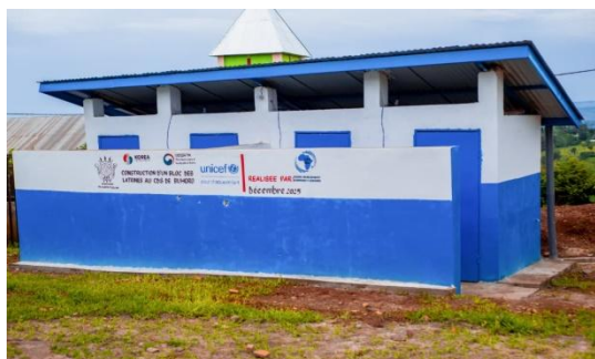
Bloc de deux toilettes et deux douches
