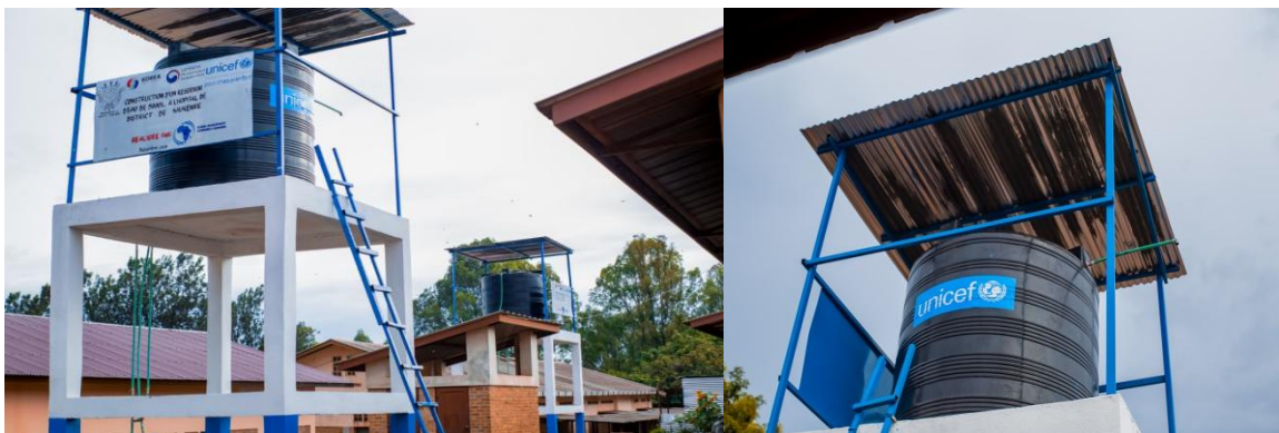
Installation de deux Polytanks 5000L
