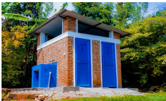
Réhabilitation des latrines, douches et point d'eau
