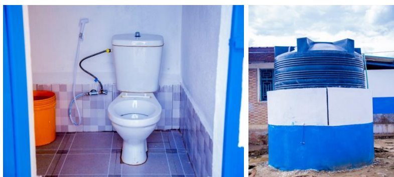
Toilettes réhabilitées pour enseignants
