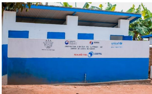
Bloc de deux latrines et douches construit
