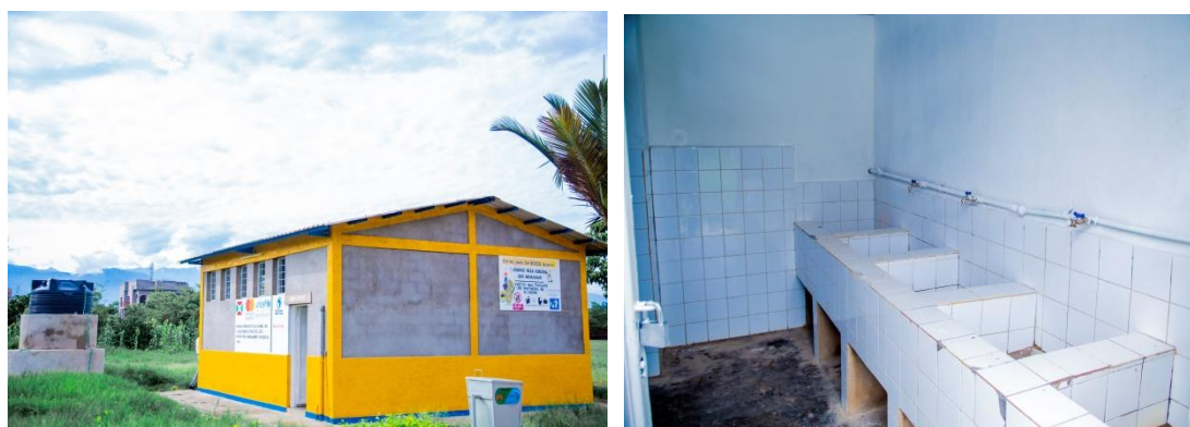
Toilettes réhabilitées et Polytank de 5000L installé réhabilités
