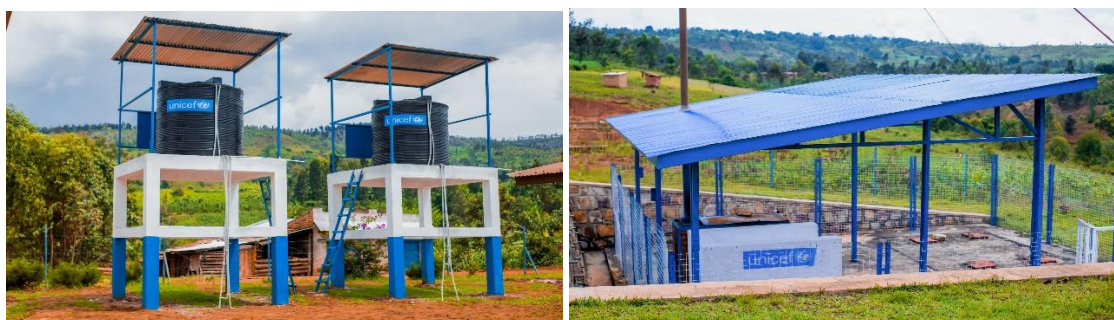
Deux Polytanks installés
