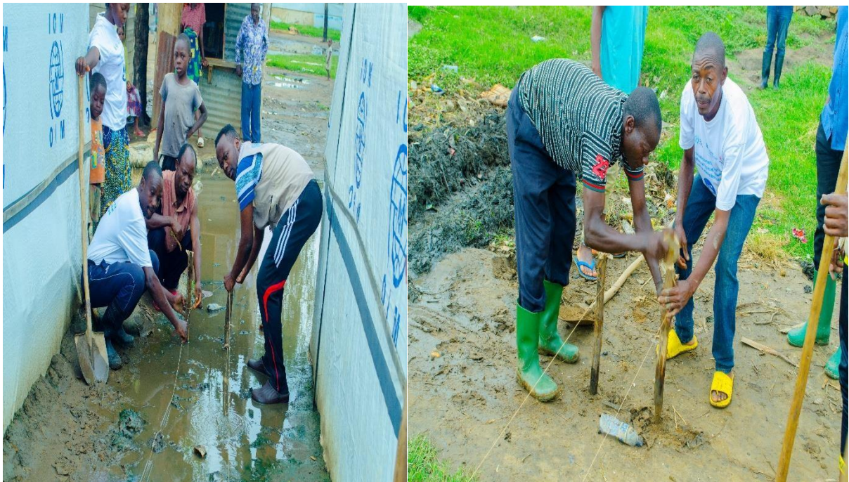
Les mesures de niveau pour la canalisation des eaux stagnantes
