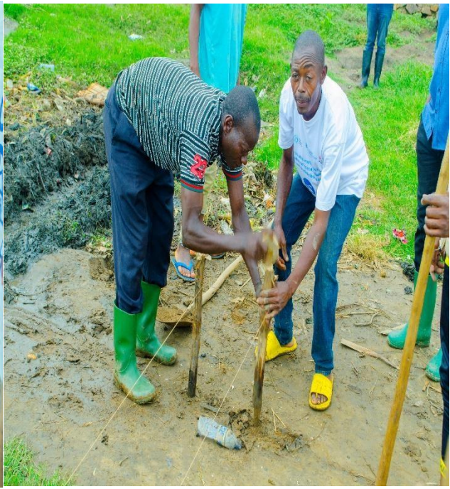
Les mesures de niveau pour la canalisation des eaux stagnantes
