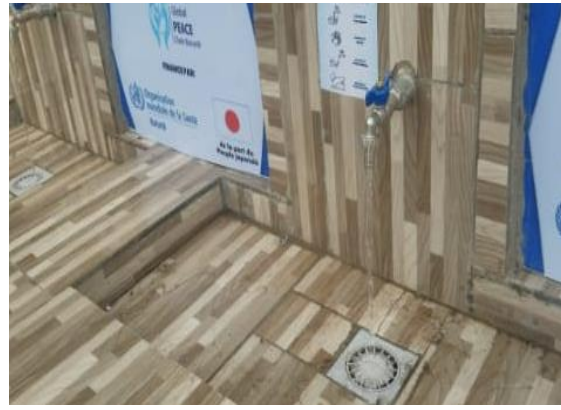
Remplacement des vannes
