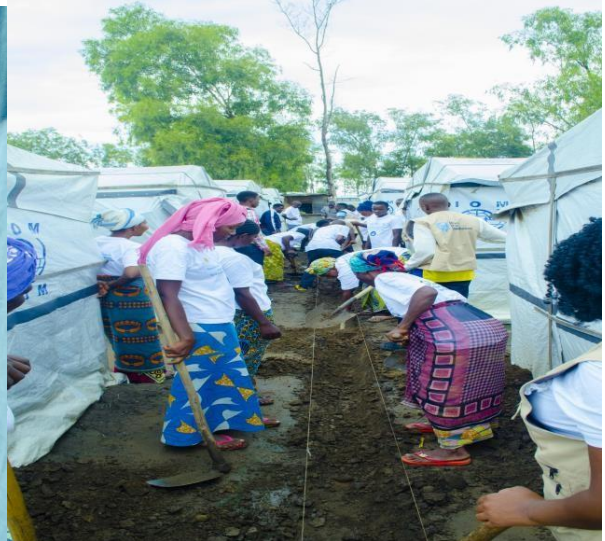
Les mesures de niveau pour la canalisation des eaux stagnantes
