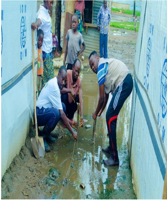
Les mesures de niveau pour la canalisation des eaux stagnantes
